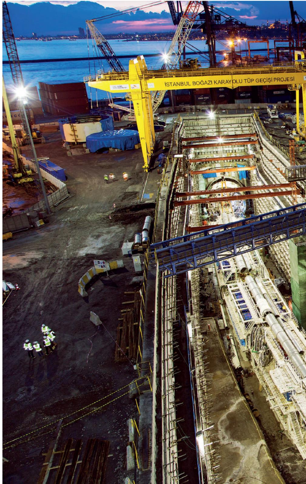
Eixo de lançamento para o Túnel Eurásia no lado asiático do Mixshield Bósforo, Istambul, Ø 13.660 mm.
