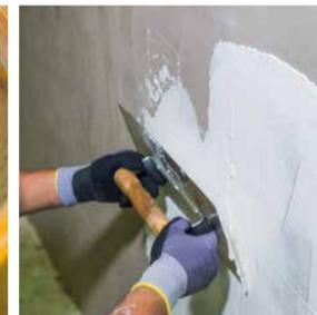
Umedeça ligeiramente a base antes da aplicação do produto e deixe a massa descansar por 5min e misturar novamente antes de iniciar a aplicação. A aplicação deve ser feita com desempenadeira lisa de aço ou de PVC diretamente sobre a superfície, com uma espessura de 0,5 ou 10mm.
