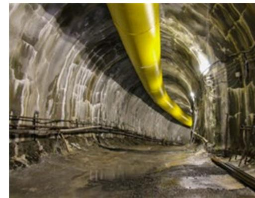
Fig 3.2: Danos devido a concreto projetado insuficientemente durável (ex.: pressão de cristalização devido ao ataque de sulfatos)
