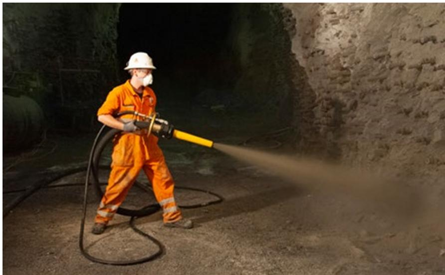
Fig 1.1: Concreto projetado por processo de fluxo aerado
