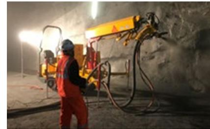
Fig. 6.5: Aliva®-503.3 - Mini sistema de projeção para concreto
