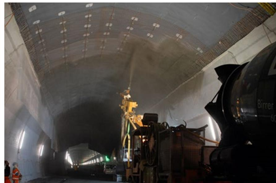
Fig 2.6: Instalação de um teto de túnel com forma variável por meio de concreto projetado na membrana com a ajuda de tela metálica (paredes foram construídas com formas e concreto in-situ)
