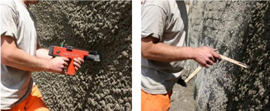
Fig. 8.4/8.5: Penetração de cavilhas em concreto recém projetado usando uma Hilti DX 450-SCT (esquerda) e medição da saliência do pino para a determinação da penetração (direita)
