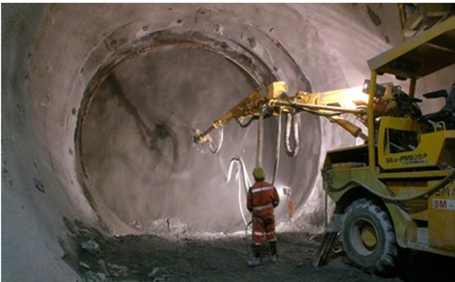
Fig. 2.2: Estabilização de escavação com concreto projetado
