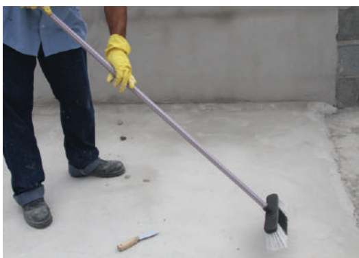
Deixe o local bem limpo, sem resíduos, restos de argamassa, madeiras, pontas de ferro, graxa, óleo e partículas soltas.
