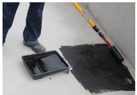
Para a aderência da SikaShield® em toda a área, incluindo rebaixos, aplique uma demão de Igol® 55 , Igol® S ou Igol® Ecoasfalto e aguarde a cura.
