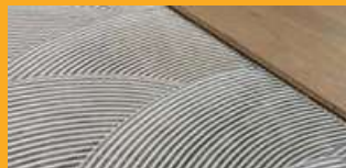
INSTALAÇÃO DE REVESTIMENTOS PISOS
