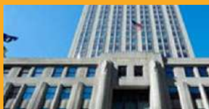
REPARO E PROTEÇÃO
