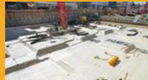
IMPERMEABILIZAÇÃO DE SUBSOLOS
