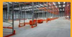
PISOS DE CONCRETO
