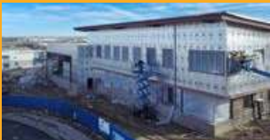
REVESTIMENTOS DA CONSTRUÇÃO
