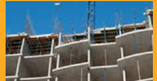
CONCRETO MOLDADO IN LOCO, USINADO E PRÉ-FABRICADO
