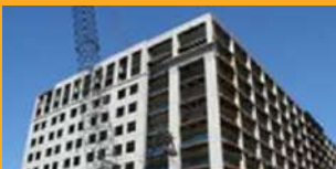
REPARO DE CONCRETO
