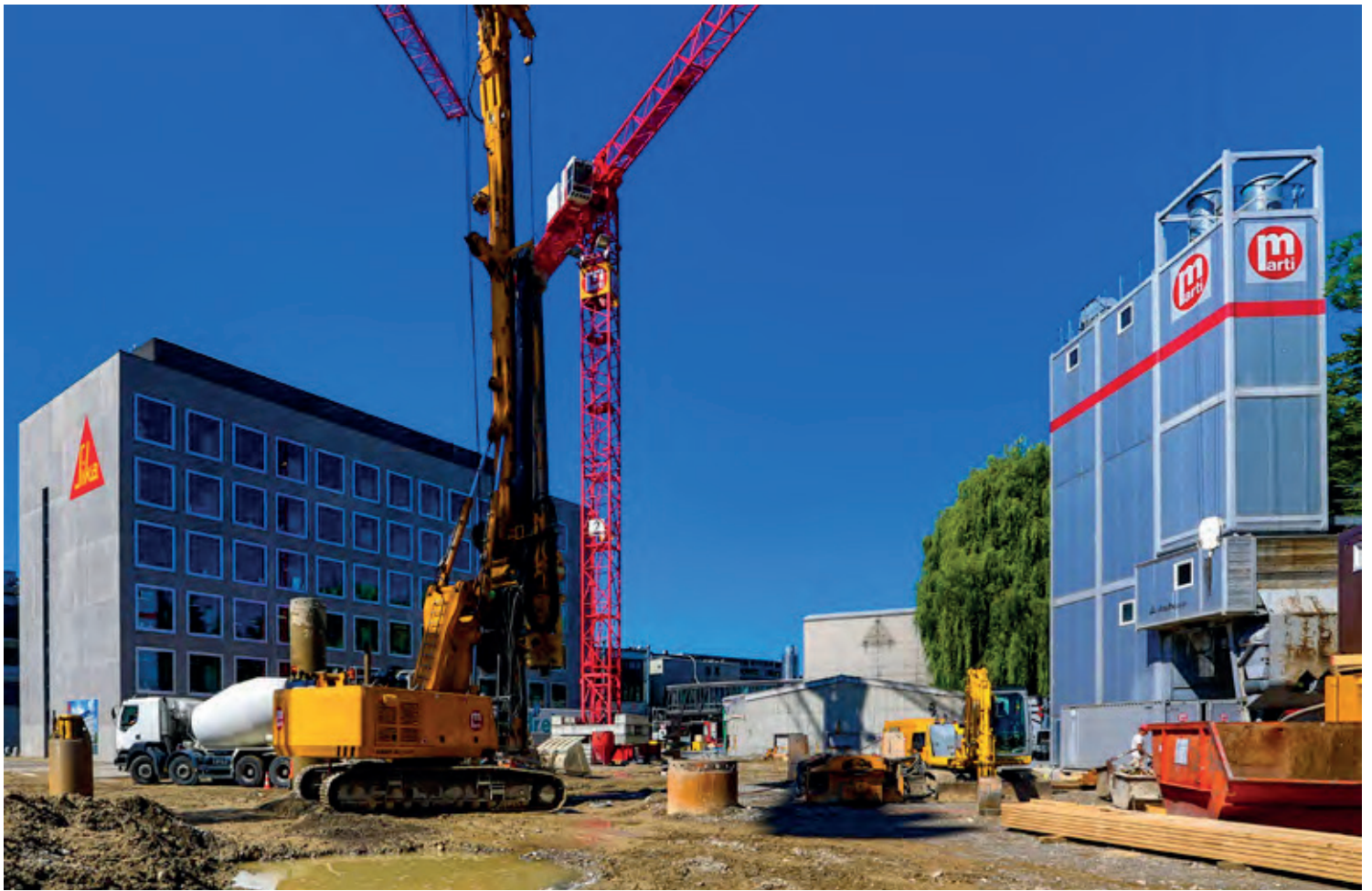
O novo edifício em andamento.
