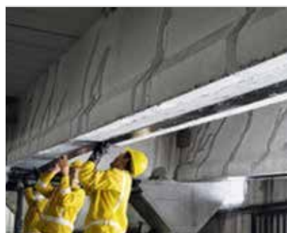
CONTROLE DE DEFORMAÇÃO E DE ABERTURA DE FISSURAS
