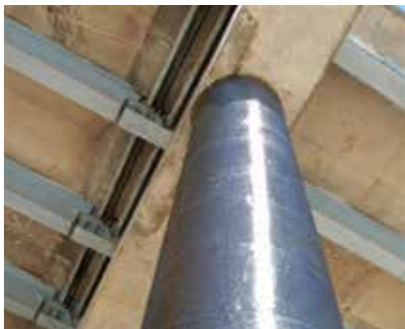
CONFINAMENTO DE PILARES
