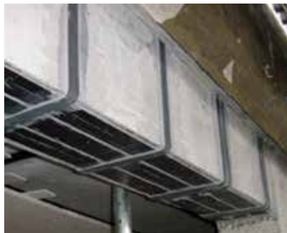
REFORÇO DE VIGAS
