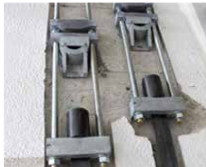
SISTEMA PROTENDIDO DE REFORÇO COM FIBRA DE CARBONO
