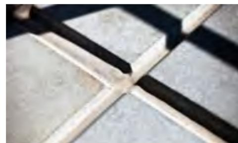
Vedação das juntas com Sikadur-Combiflex® entre os elementos de concreto reforçados pré-fabricados.
