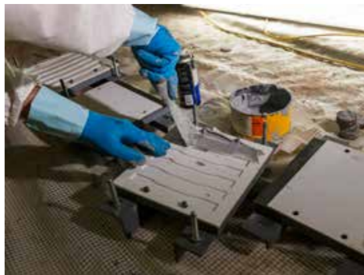
Aplicação do adesivo Sikadur®-30 às lâminas de fibra de carbono.
