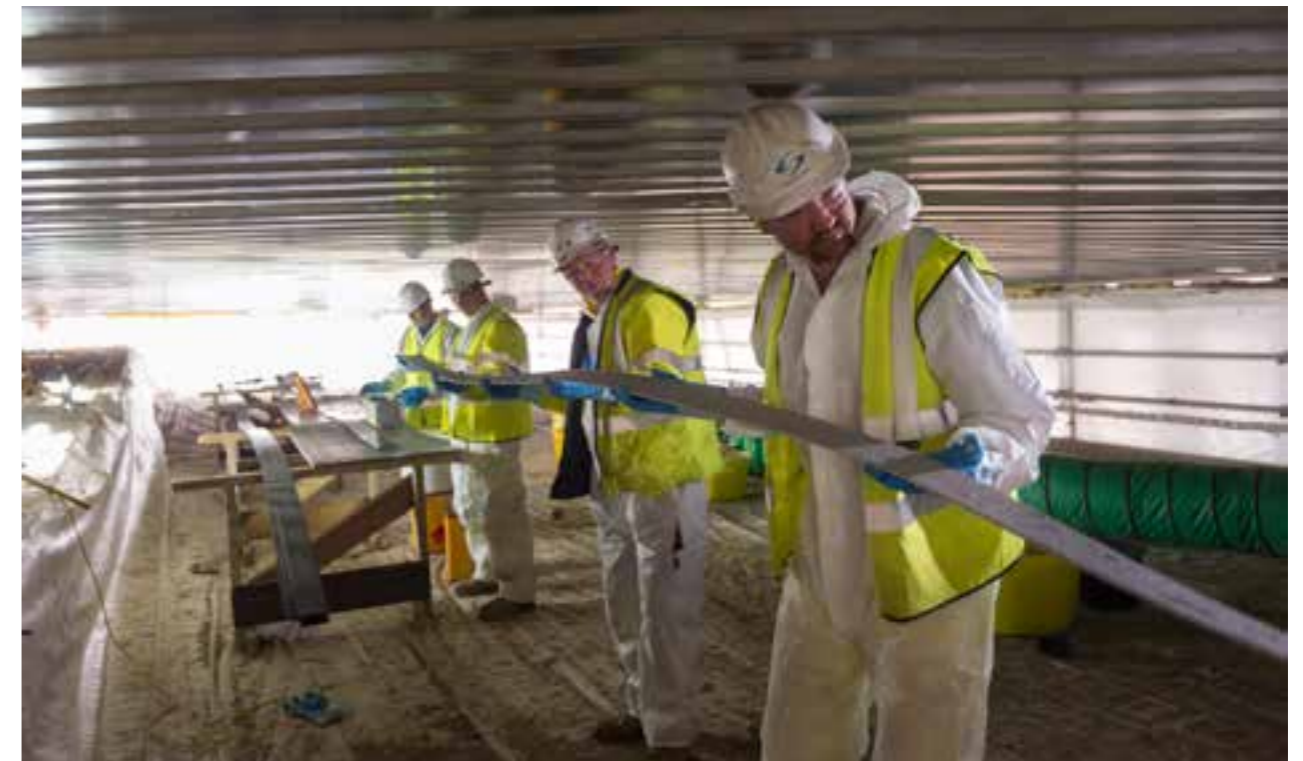
Instalação de chapas de fibra de carbono Sika® CarboDur®.
