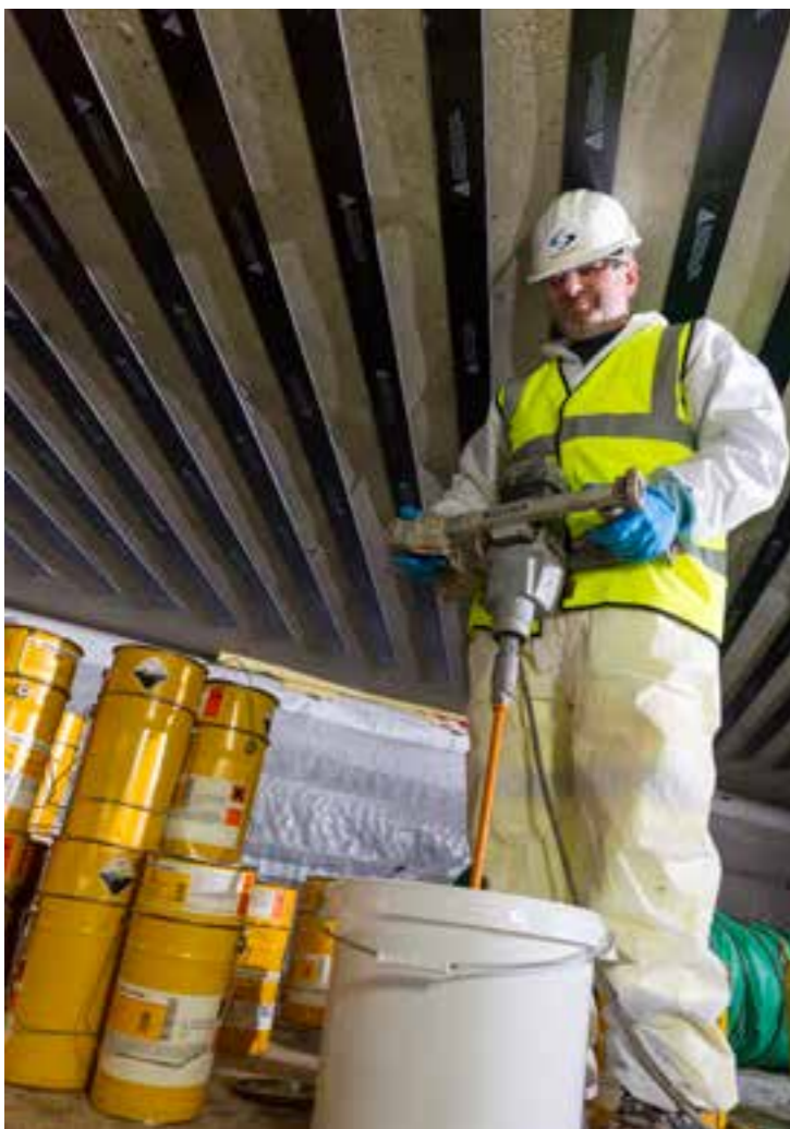
Aplicação do adesivo Sikadur®-30 às lâminas de fibra de carbono.
