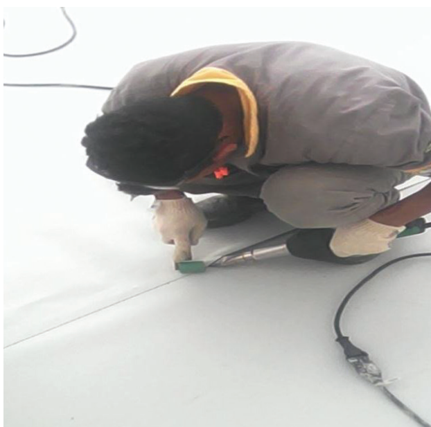
Área Expedição Acondicionamento (95m 2 ). Depois do tratamento.
