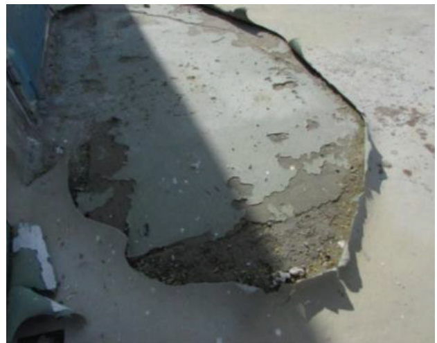
Área Expedição Acondicionamento (95m 2 ). Antes do tratamento.
