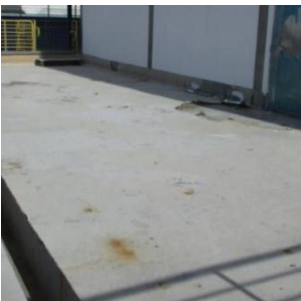
Área Expedição Acondicionamento (95m 2 ). Antes do tratamento.
