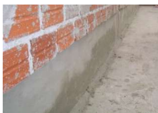
Engaste da impermeabilização na vertical 20cm acima do piso acabado.
