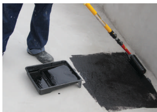
Para a aderência da Sika® Manta Asfáltica em toda a área, incluindo rebaixos, aplique uma demão de Igol® 55 , Igol® S ou Igol® ECO Asfalto e aguarde a cura.
