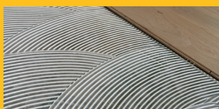
INSTALAÇÃO DE REVESTIMENTOS PISOS
