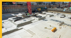
IMPERMEABILIZAÇÃO DE SUBSOLOS
