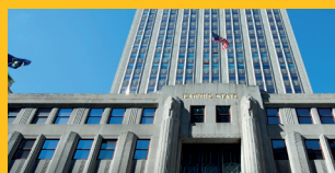
REPARO E PROTEÇÃO
