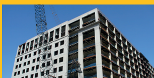
REPARO DE CONCRETO
