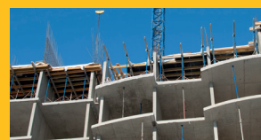
FUNDIÇÃO IN-SITU E PRÉ-FABRICADOS DE CONCRETO
