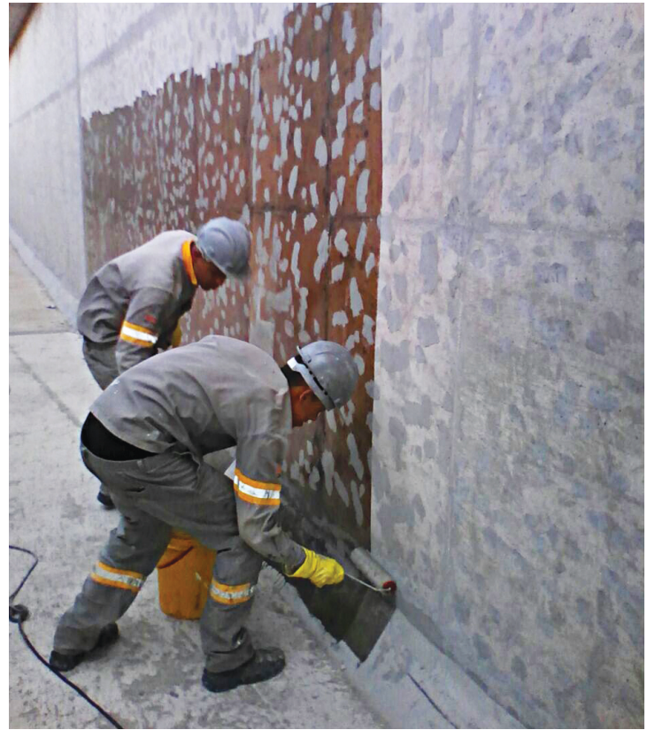
Aplicação de prime promotor de aderência Sikafloor®-161.
