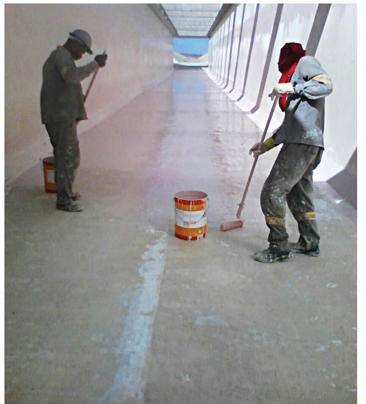
Aplicação de Sistema Imperm. de Alto Desempenho Sika® Icosit K 101 TW.
