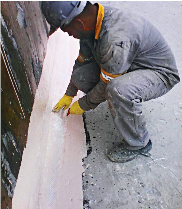
Aplicação de estruturante Sikaglass®-300 com Sika® Icosit K 101 TW.
