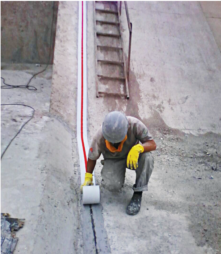
Aplicação do Sistema Sikadur® Combiflex nas Juntas das transições e dilatação.
