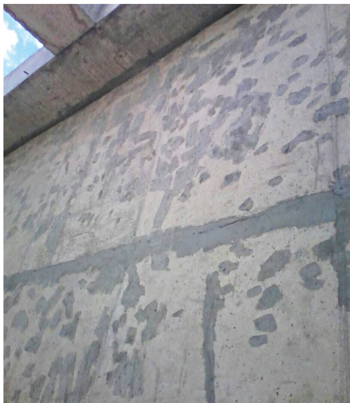
Equalização da superfície e correção de trincas e erosões do concreto.
