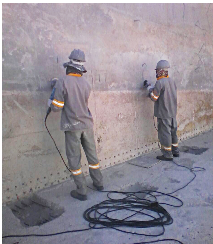
Lixamento da superfície do piso e parede.
