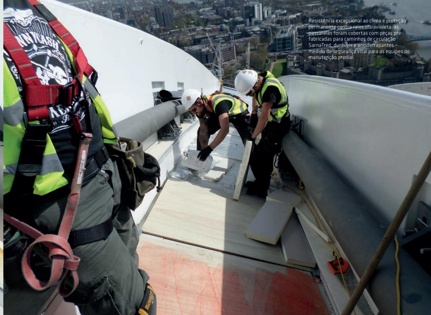
Resistência excepcional ao clima e proteção permanente contra raios ultravioleta: as passarelas foram cobertas com peças pré-fabricadas para caminhos de circulação SarnaTred, duráveis e antiderrapantes – medida de segurança vital para as equipes de manutenção predial.
