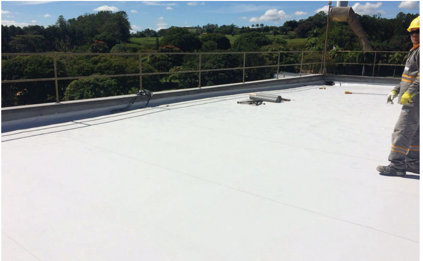
Impermeabilização de alto desempenho com membrana de PU.
