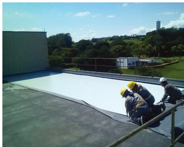
Impermeabilização de alto desempenho com manta de PVC.
