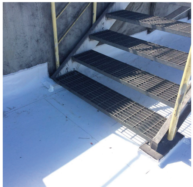
Impermeabilização de alto desempenho com manta de PVC.
