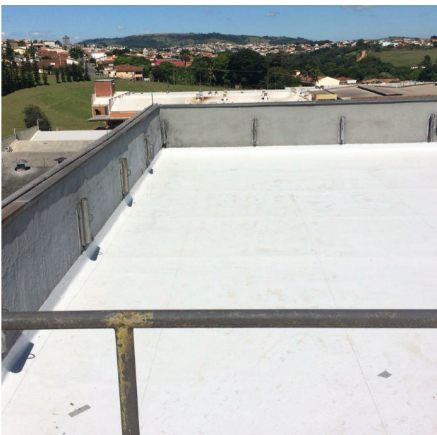
Impermeabilização de alto desempenho com manta de PVC.
