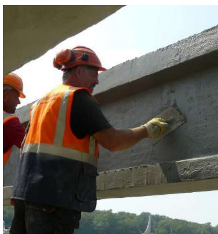
Recuperação e Proteção de Estruturas
