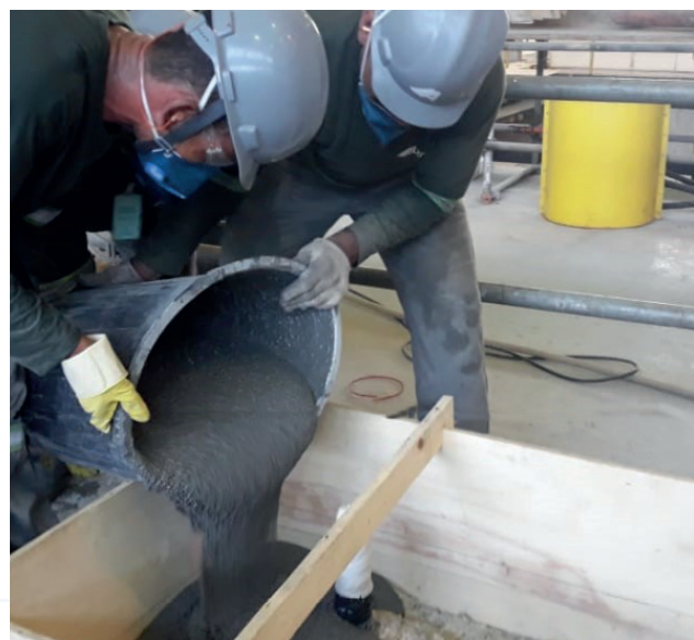
Aplicação do graute epóxi Sikadur®-42 BR.
