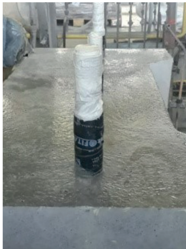
Detalhe da base depois da execução com Sikadur®-42 BR.
