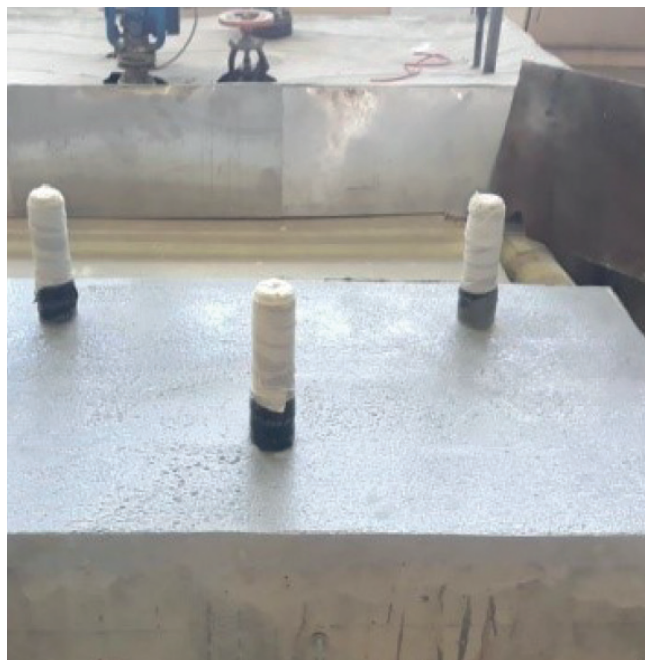
Nova base da turbina, realizada com Sikadur®-42 BR.
