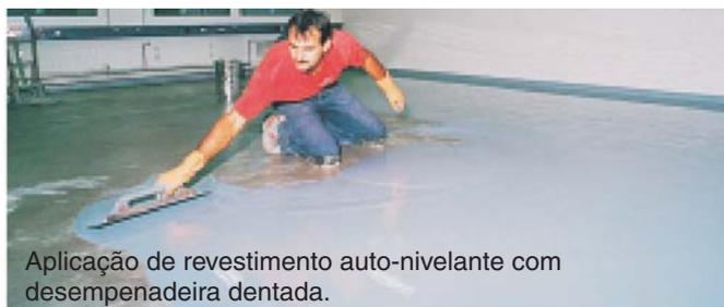
Aplicação de revestimento auto-nivelante com desempenadeira dentada.
