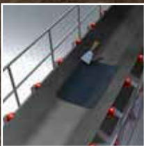
Reparação e adesivo para correia transportadora
