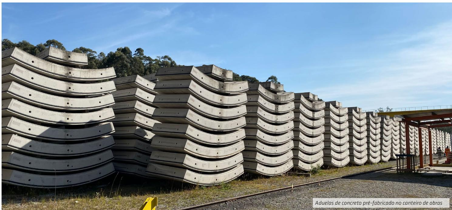
Aduelas de concreto pré-fabricado no canteiro de obras
