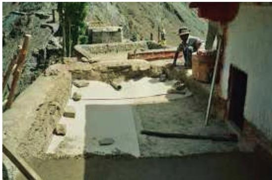
Um dos problemas encontrados foi a relativa fragilidade estrutural do teto, evidenciada pelos danos causados por infiltrações. Essa estrutura apoiava a camada mais espessa e pesada do telhado.
