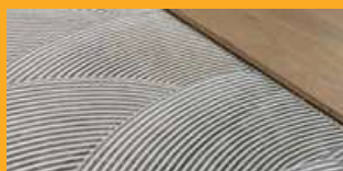
INSTALAÇÃO DE REVESTIMENTOS PISOS
