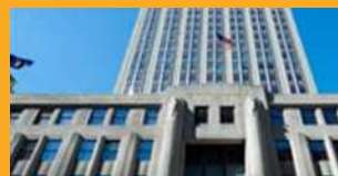
REPARO E PROTEÇÃO
