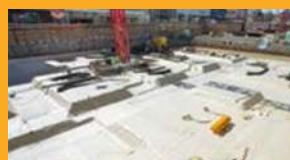
IMPERMEABILIZAÇÃO DE SUBSOLOS
