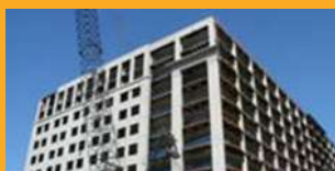
REPARO DE CONCRETO
