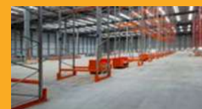
PISOS DE CONCRETO
