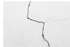
Trincas e fissuras
