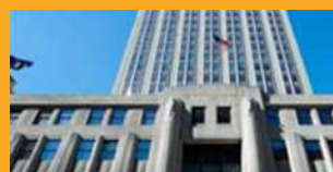
REPARO E PROTEÇÃO
