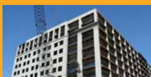
REPARO DE CONCRETO
