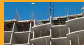
CONCRETO MOLDADO IN LOCO, USINADO E PRÉ-FABRICADO
