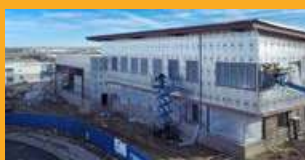
REVESTIMENTOS DA CONSTRUÇÃO
