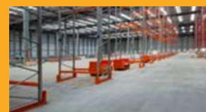
PISOS DE CONCRETO
