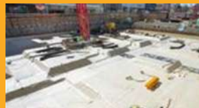
IMPERMEABILIZAÇÃO DE SUBSOLOS
