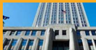
REPARO E PROTEÇÃO
