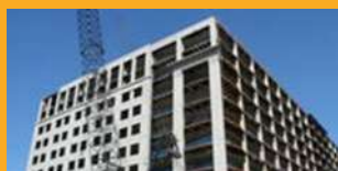
REPARO DE CONCRETO
