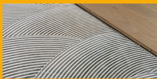
INSTALAÇÃO E COLAGEM DE REVESTIMENTOS
