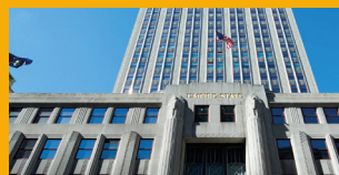
REPARO E PROTEÇÃO
