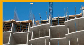
CONCRETO PRÉ-FABRICADO E MOLDADO NO LOCAL
