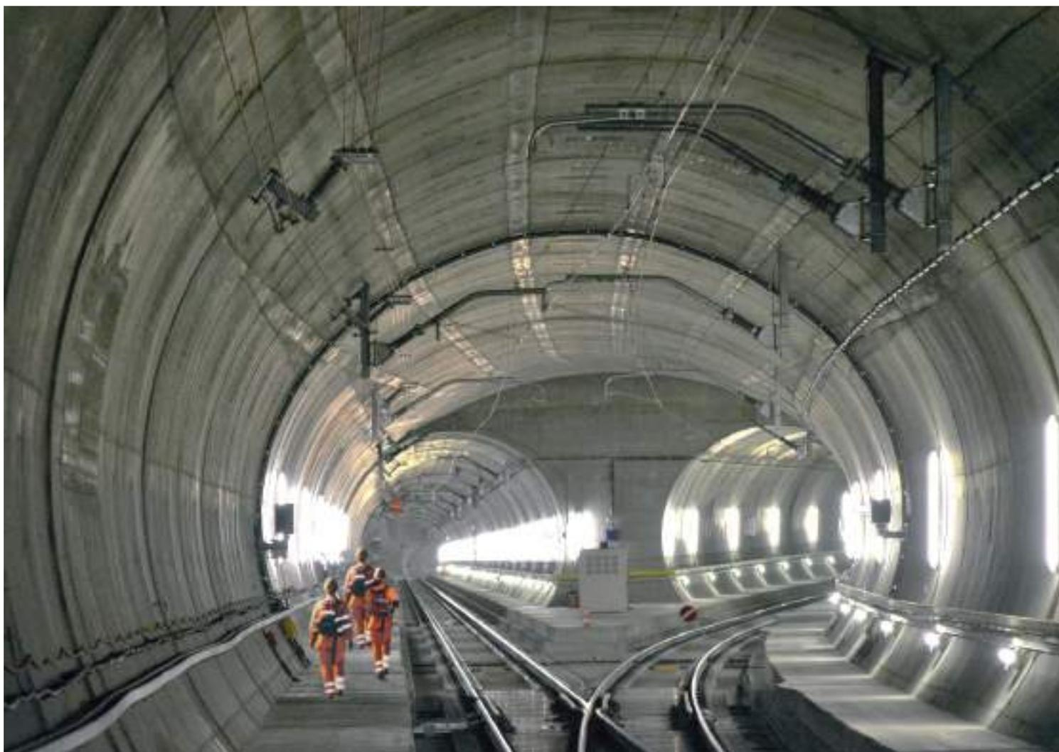
Até 260 trens de carga e 65 de passageiros podem atravessar o túnel por dia. A velocidade máxima para trens de carga é de 160 km/h. Trens de passageiros podem desenvolver até 250 km/h.
