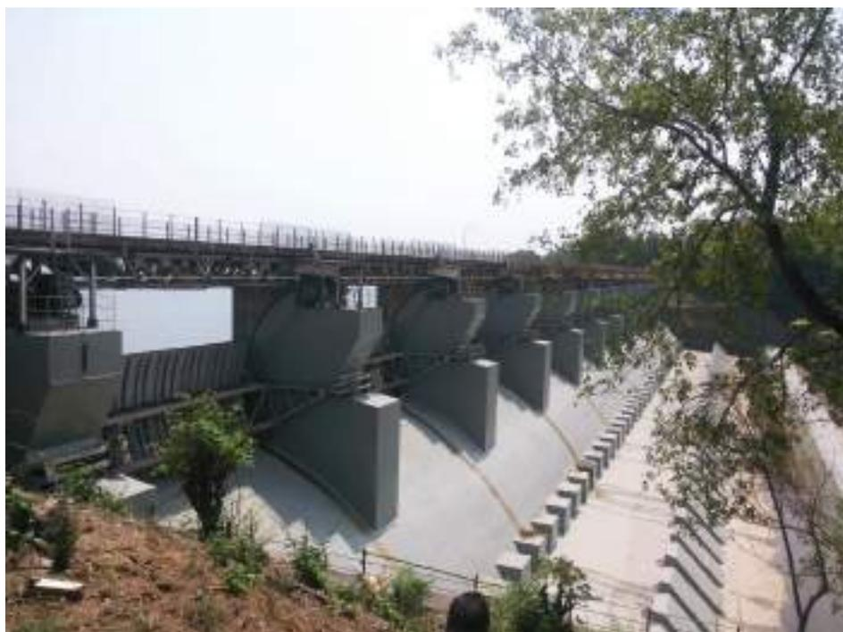
mas foi tratada com Sikadur®-31 e Sikagard® para aumentar a vida útil do concreto utilizado. As rachaduras e espaços encontrados em toda a barragem foram tratados com injeção superficial de resina epóxi de baixa viscosidade – ou seja, com Sikadur®-52. As juntas de construção e expansão, por sua vez, foram reparadas com o sistema de fitas impermeabilizantes Sikadur-Combilex® SG.
