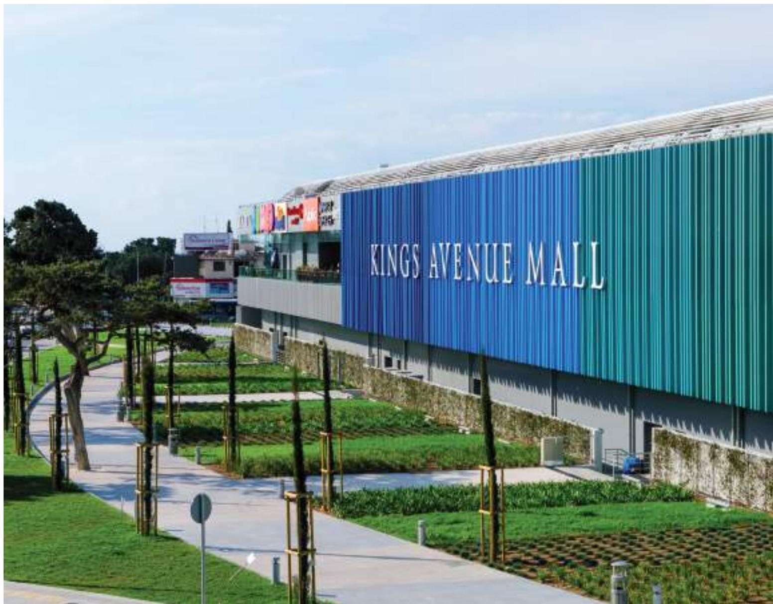
A impressionante fachada exterior é composta por um sistema de alumínio leve com estrutura interna em forma de favo, desenvolvido e fabricado pela empresa grega Metallock.
