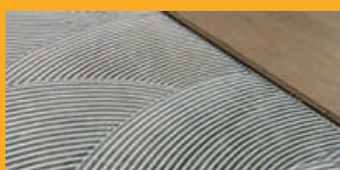
INSTALAÇÃO DE REVESTIMENTOS
