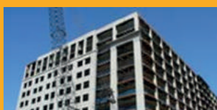
REPARO DE CONCRETO
