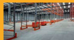
PISOS DE CONCRETO
