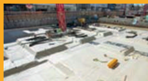
IMPERMEABILIZAÇÃO DE SUBSOLOS
