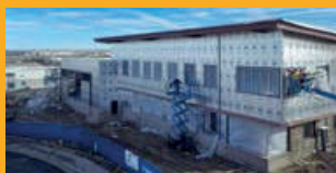
REVESTIMENTOS DA CONSTRUÇÃO
