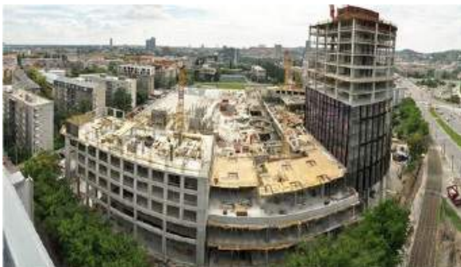
O Central, ainda na fase de construção. Hoje, seu telhado ecológico oferece um ambiente natural com 6.000 m 2 e diversas opções de descanso e lazer para toda a família.
