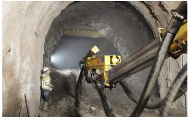
As macrofibras sintéticas SikaFiber® Force foram adicionadas ao concreto projetado para aumentar a durabilidade do revestimento de concreto. O concreto reforçado com essas fibras produziu um suporte mais eficiente da escavação e com melhor custo-benefício.
