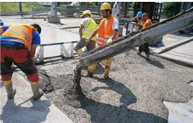
As macrofibras sintéticas SikaFiber® Force foram usadas em combinação com o método alemão chamado White-Topping para reparar lajes em um terminal de petróleo em Stuttgart. As fibras foram usadas para melhorar o comportamento à fadiga do novo recobrimento de concreto.
