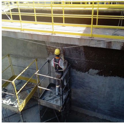
Aplicação de argamassa de polimérica para reparos em estruturas de concreto.
