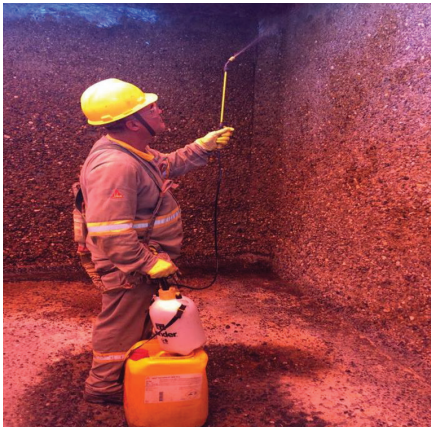
Aplicação de inibidor de corrosão misto..
