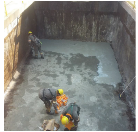
Aplicação de barreira temporária ao vapor.
