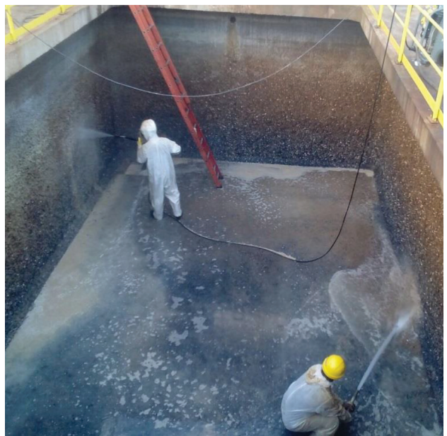
Preparação de superfície com hidrojateamento e descontaminação.
