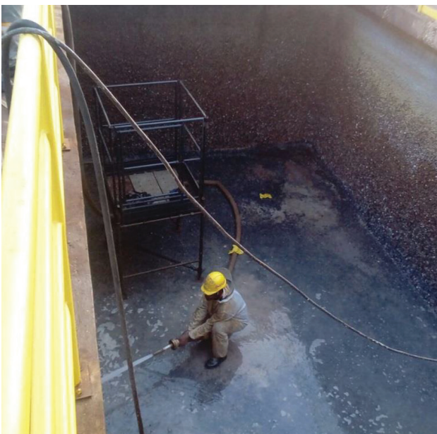
Preparação de superfície com hidrojateamento e descontaminação.
