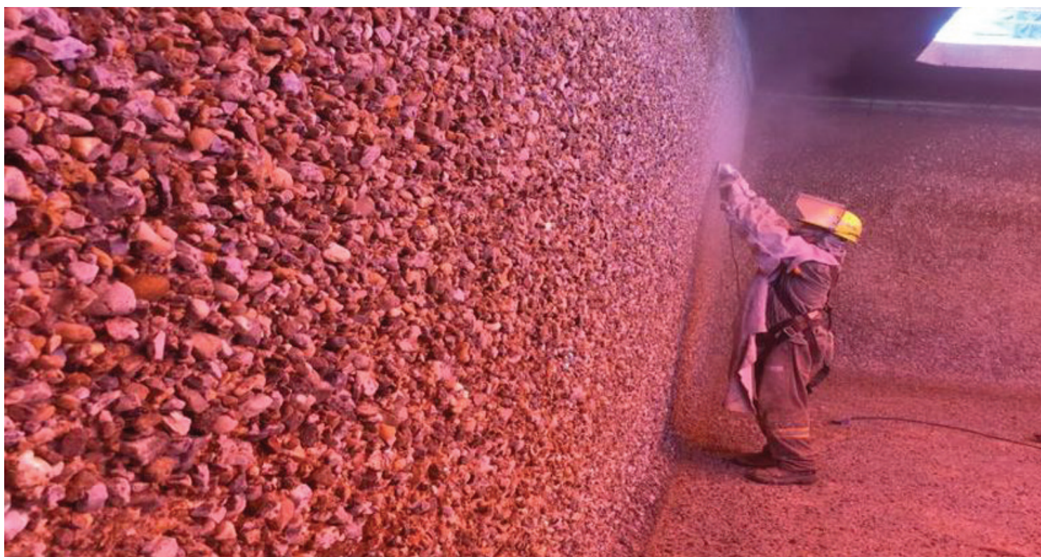
Lixamento para promover ancoragem na superfície.
