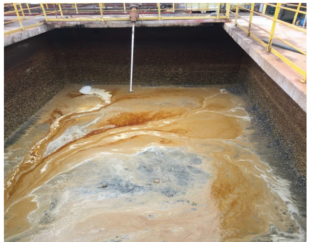
Detalhe da superfície do tanque ante da aplicação do sistema.
