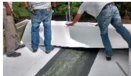
Aplicação manual da manta
