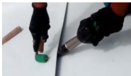
Soldagem dos transpasses com ar quente 500°C
