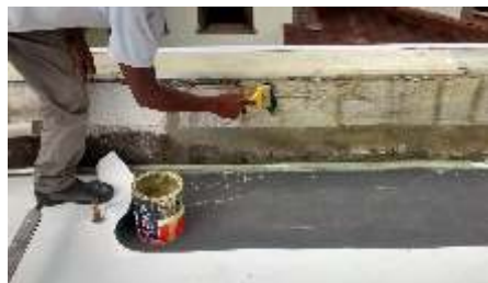
Preparo do substrato para colagem da manta
