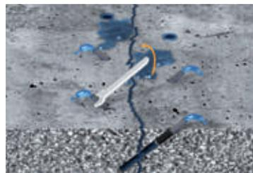
**2.** Instale os bicos mecânicos. Aperte-os para que eles possam resistir à máxima pressão de injeção.
