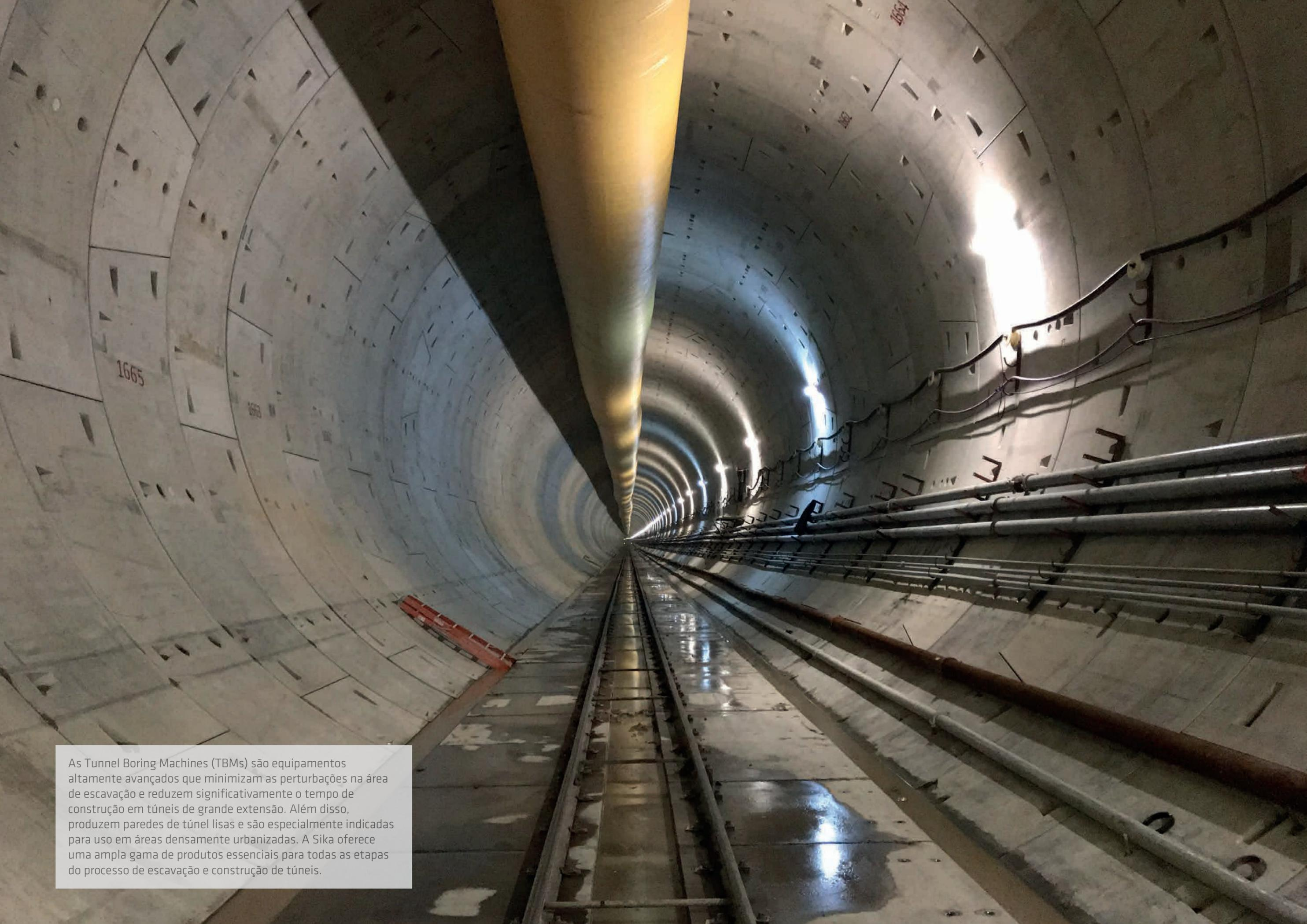
As Tunnel Boring Machines (TBMs) são equipamentos altamente avançados que minimizam as perturbações na área de escavação e reduzem significativamente o tempo de construção em túneis de grande extensão. Além disso, produzem paredes de túnel lisas e são especialmente indicadas para uso em áreas densamente urbanizadas. A Sika oferece uma ampla gama de produtos essenciais para todas as etapas do processo de escavação e construção de túneis.
