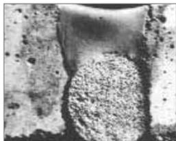
O diâmetro do Sika® Rod a aplicar deve ser cerca de 25% superior à largura máxima da junta a selar. Deste modo garante-se a uniformidade da Profundidade da junta do selante e/ou seu correto posicionamento.
