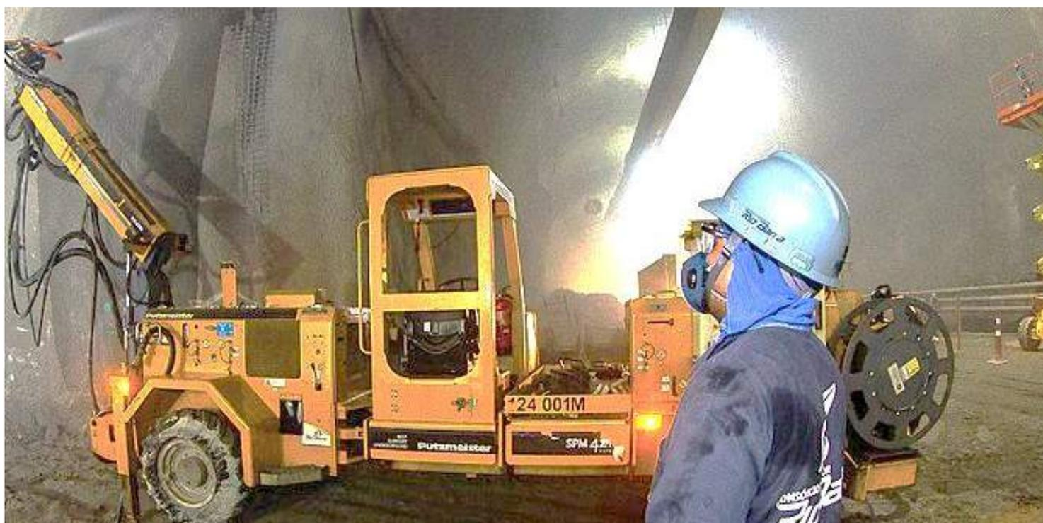
Tanto para o concreto secundário (o concreto estrutural dos túneis escavados pelo método NATM) como para o concreto armado (usado nas estações e poços) foram usadas as linhas de aditivos **Sika ViscoCrete**®, **Sika ViscoFlow**® e **SikaMent**®. Compostas por plastificantes e superplastificantes, elas produzem concreto de alto desempenho (CAD) e têm um alto poder de redução de água, permitindo a confecção de concretos mais compactados, com altíssima fluidez e trabalhabilidade adequada.
