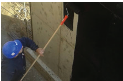
Prepare a superfície e aplique o Igol® Eco Asfalto
