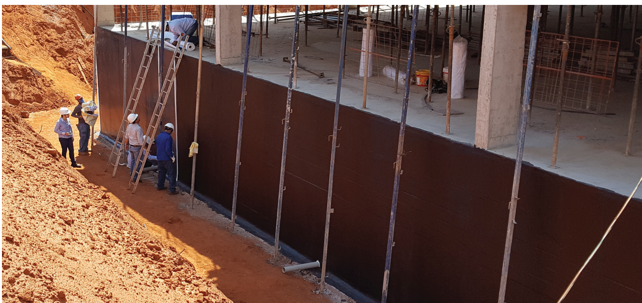
Reforçe as emendas com uma tira com o próprio SikaBit®S-515 BR ou com Sika MultiSeal®.
