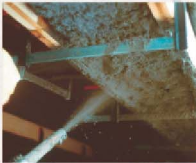
Aplicação por Projeção de Argamassas de Reparo.
